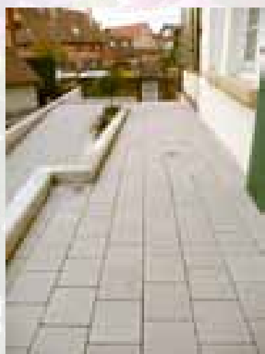
Rampe d'accès pour personnes à mobilité réduite
