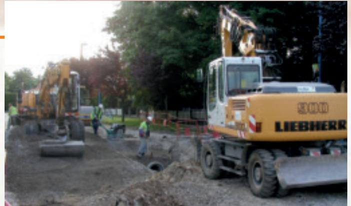
Deux pelles hydrauliques simultanément en action, l'une pour la pose du nouveau réseau d'assainissement, l'autre pour la création de la nouvelle structure de chaussée de la rue du Chemin de Fer.
