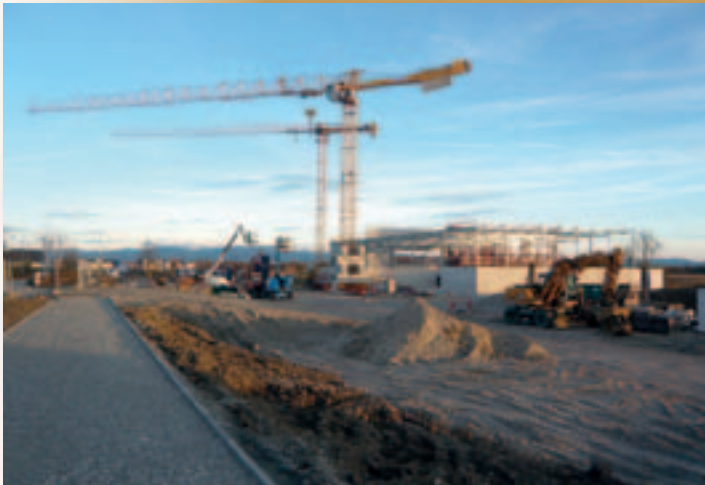
20 000 m 3 de travaux de terrassements
