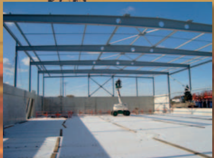
La future salle de gymnastique
