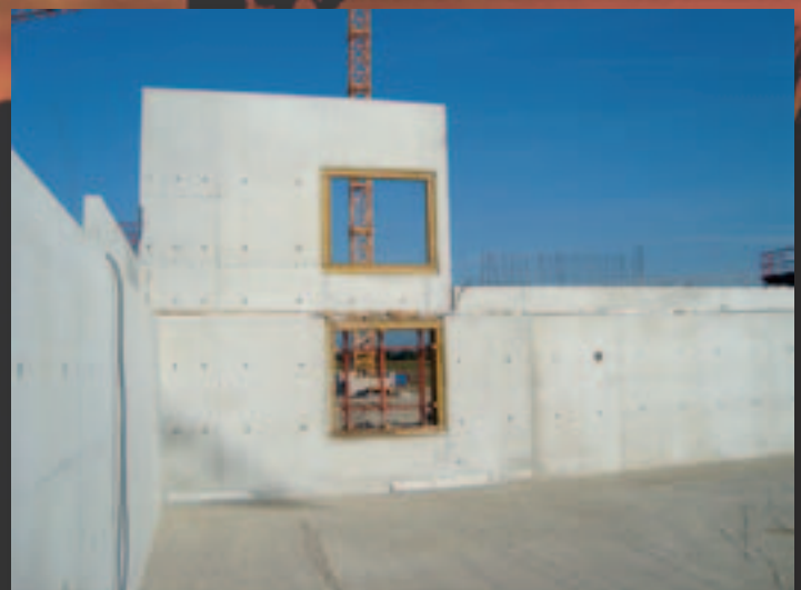
3 200 m 2 de murs en béton banché
