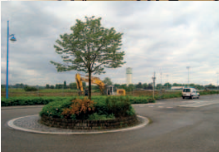
19 000 m 2 de décapage de terre végétale
