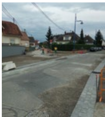
Rue Gruber en chantier
