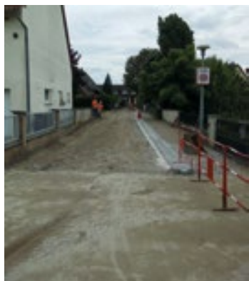
Rue du Bitzig en chantier
