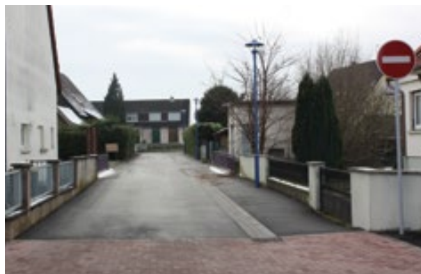
Rue du Bitzig après travaux
