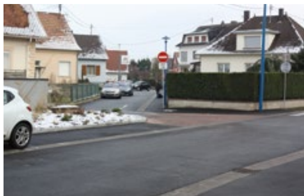
Rue Gruber après travaux
