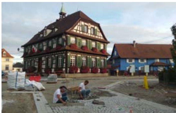
Travaux devant la Mairie
