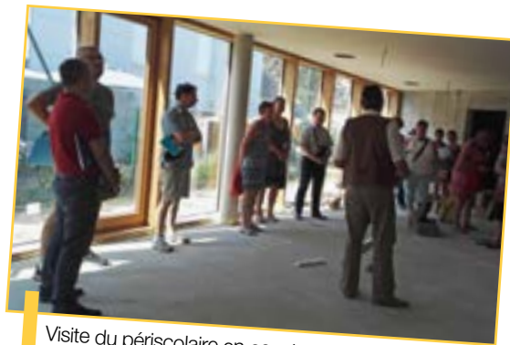
Visite du périscolaire en construction avec le comité de pilotage - COMMUNE DE GAMBSHEIM.
