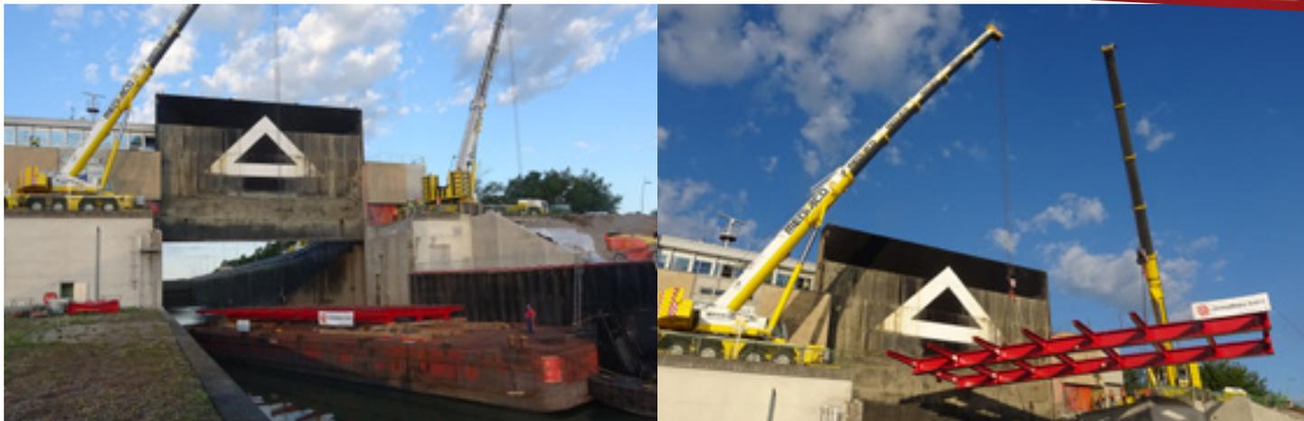
Les poutres rouges fabriquées en Lorraine et assemblées au port autonome de Strasbourg, sont arrivées via le Rhin sur une barge avec pousseur. Deux grues ont été nécessaires pour hisser cet ensemble et le caler sur les bords en béton.
