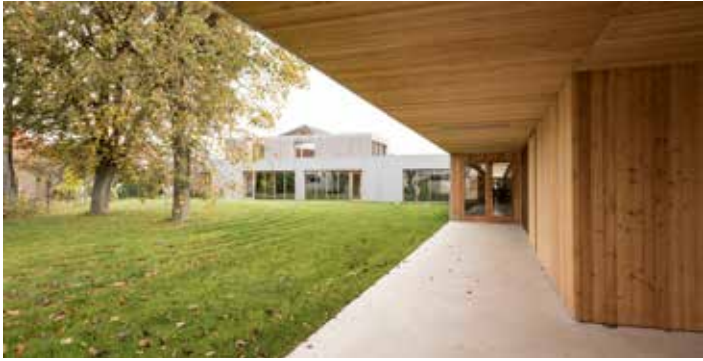
Belle ouverture des salles du périscolaire sur les espaces verts.
