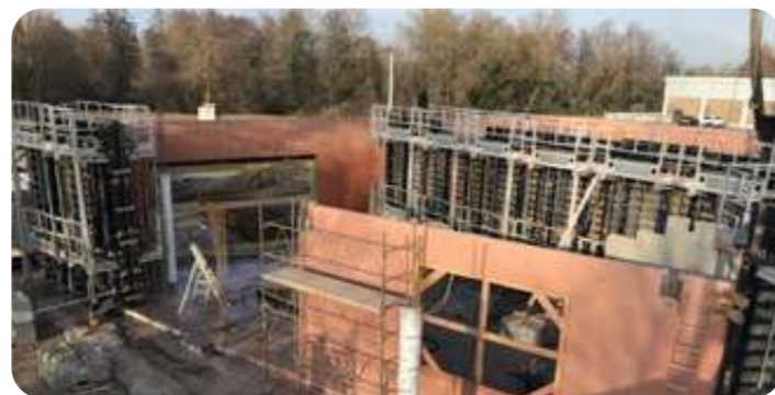
Chantier de la future Maison de Service
