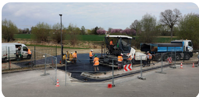
Travaux d'amélioration des accès à la déchèterie de Gamsheim
