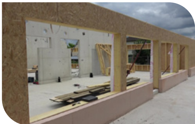
27 mai 2025 : démarrage de la pose des murs à ossature bois
