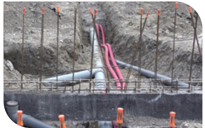
24 mars : réservations sanitaires, assainissement, électricité
