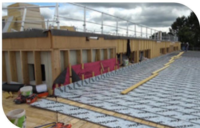
04 août : pose du zinc et des garde-corps de sécurité
