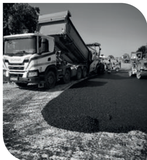
Mise en œuvre de la nouvelle couche de roulement en enrobés.
