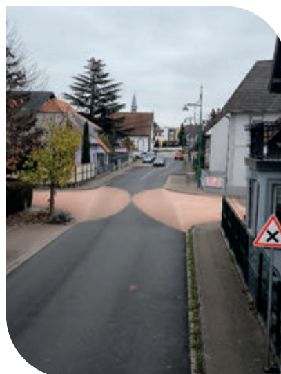
Route de Weyersheim au croisement - rue de la Chapelle - rue des Lilas après les travaux de voirie.
