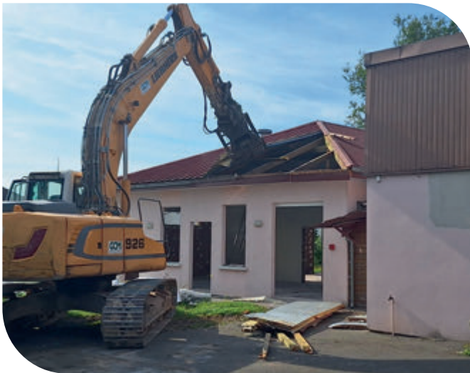
Démolition de la classe de Petite Section.
