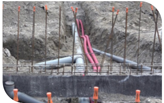
24 mars : réservations sanitaires, assainissement, électricité
